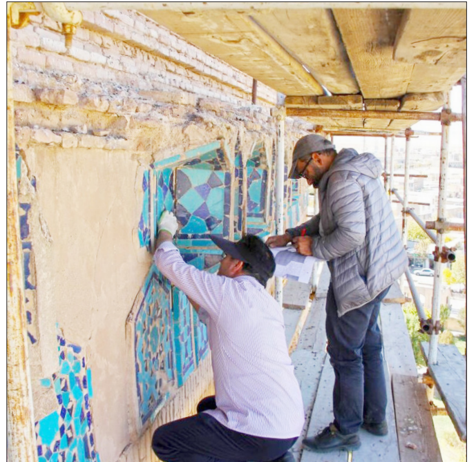
آغاز عملیات حفاظت و مرمت مقرنس‌های ضلع شمال غربی گنبد سلطانیه
